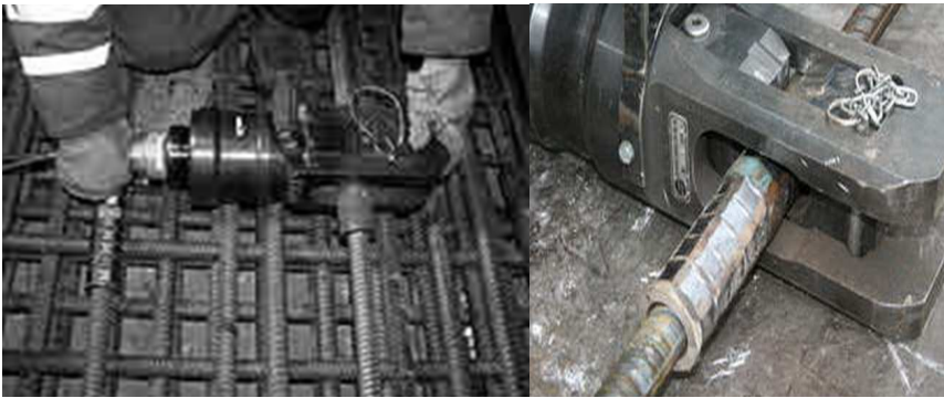
Рис. 5. З'єднання муфти з арматурою гідравлічним пресом
