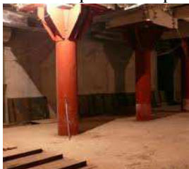
Рис. 1 – Возведение каркаса здания с применением трубобетонных колонн: подземная и надземная части здания
