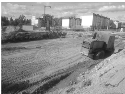
Рис. 7. Уплотнение грунтовой подушки и природного грунта в верхней зоне основания виброкатком
