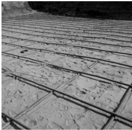
Рис. 3. Горизонтальное армирование грунтовой подушки
