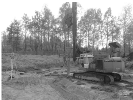
Рис. 6. Установка для вибропогружения обсадной трубы с теряемым наконечником
