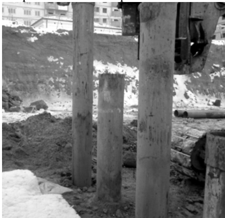
Рис. 2. Устройство вертикальных армирующих элементов
