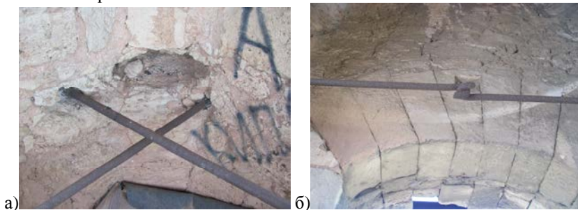
Рис. 8. Ранее установленные элементы усиления стен затяжками из круглой стали колокольни Балаклавского Георгиевского монастыря.
