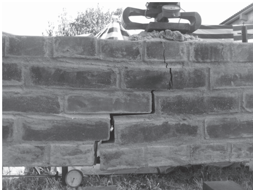
Рис. 9. Общий вид балки перед разрушением
