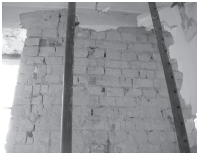
Рис. 7. Руйнування кладки простінку
