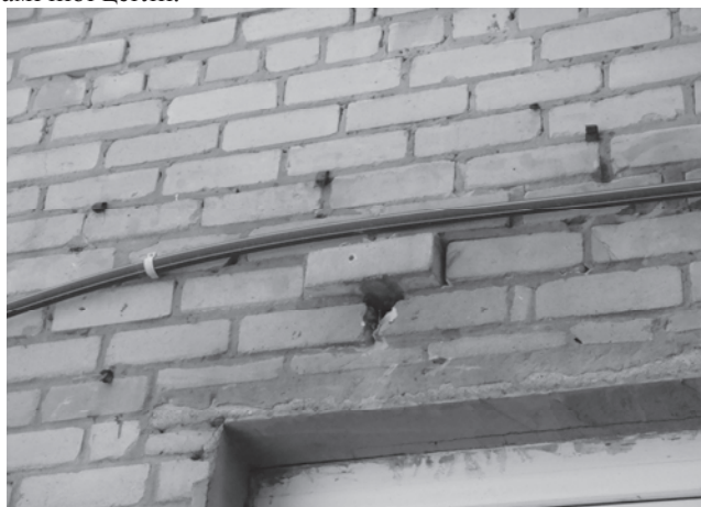
Рис. 6. Випробовування цегли та відбір зразків розчину з кладки
