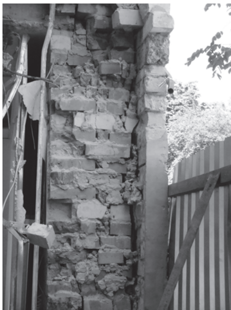
Рис. 3. Конструкція зовнішньої несучої стіни
