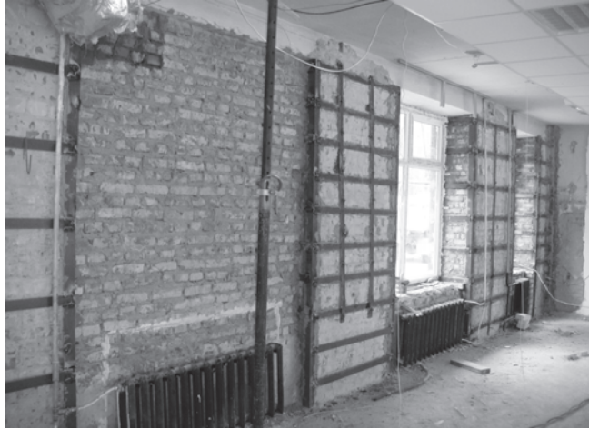
Рис. 10. Підсилення простінків сталевими обіймами
