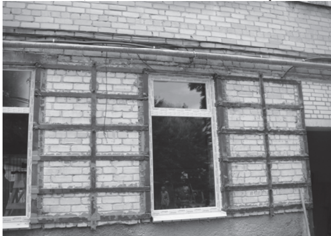
Рис. 9. Підсилення простінків сталевими обіймами
