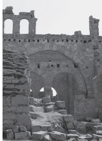
Рис.4. Признаки деформирования распорных систем:
