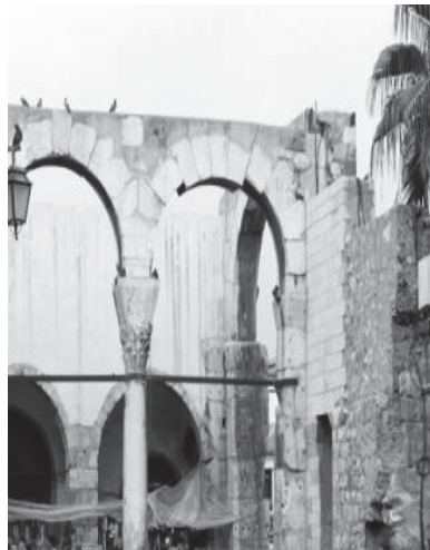
Рис.4. Признаки деформирования распорных систем:
