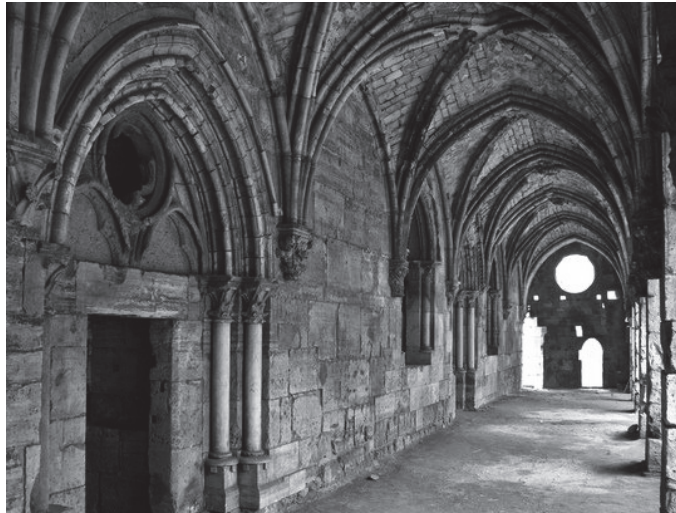
Рис.3 Стрельчатая форма арки в галереях крепости Аль-Хосн, Хомс
