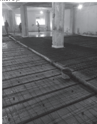
Рис. 3. Установка арматуры и укладка бетона усиления плит перекрытия
