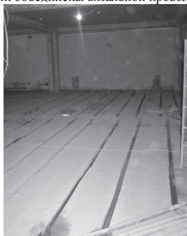
Рис. 2. Выполнение прорезей в плитах перекрытий
