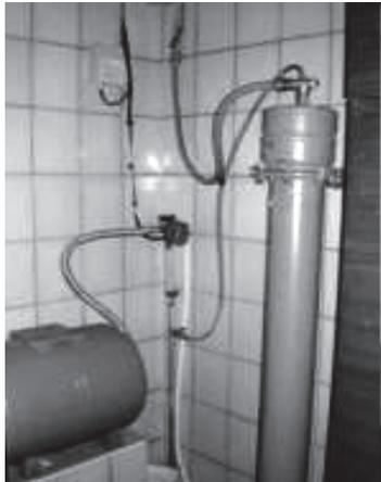
Рис. 2. Напірний фільтр для знезалізнєння води з модифікованою пінополістирольною засипкою
