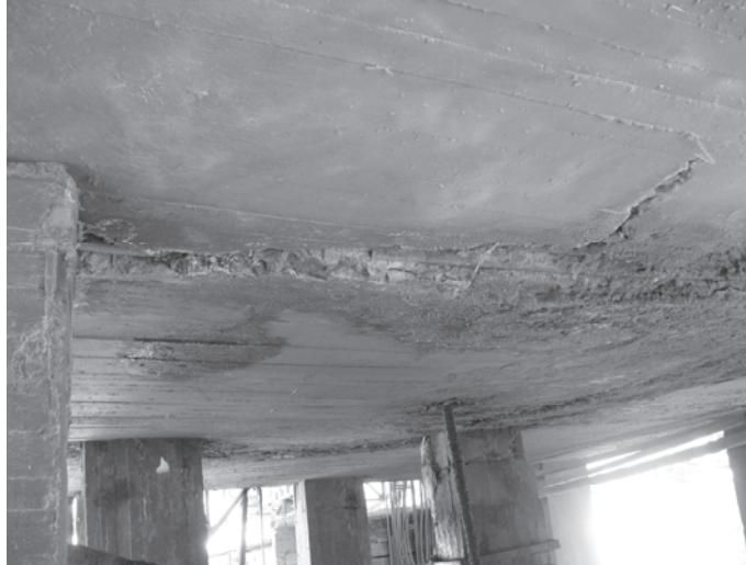
Фото. 8. Тріщини у нижній зоні верхньої плити опори П5/О4 Залізобетонні колони та ребристе перекриття опори П4/О4 (рис. 9) мають ті ж дефекти і пошкодження, що й в опорах П5/О4 та П6/О4.
