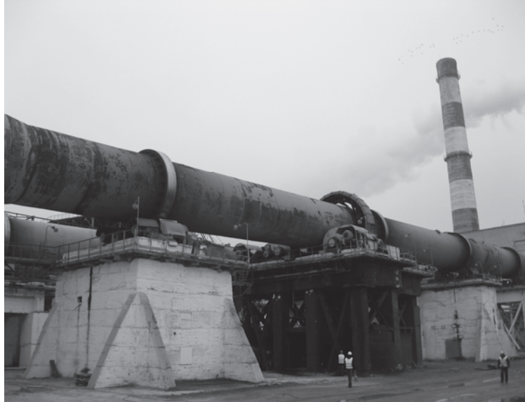
Фото. 1. Загальний вигляд опор обертових печей
