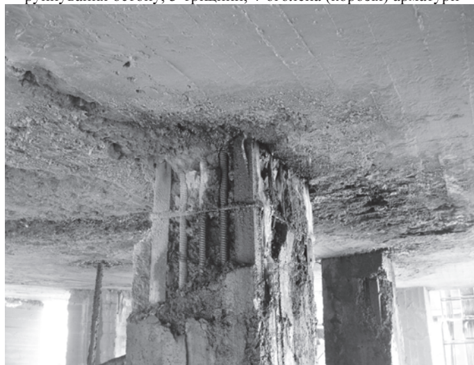
Фото. 7. Обпирання плити на колону опори П5/04
