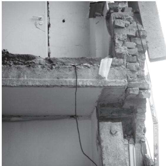
Фото 7. Величина обпирання плити перекриття на зовнішню стіну
