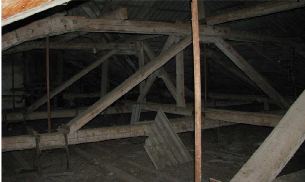
Рис. 1. Загальний вигляд дерев'яних конструкцій покрівлі ЗОШ №7 м. Дубно
