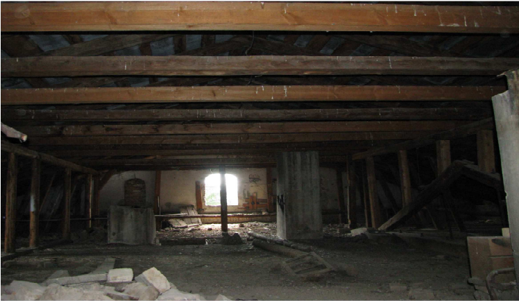
Рис. 4. Загальний вигляд дерев'яних конструкцій покрівлі адміністративної будівлі в м. Дубно
