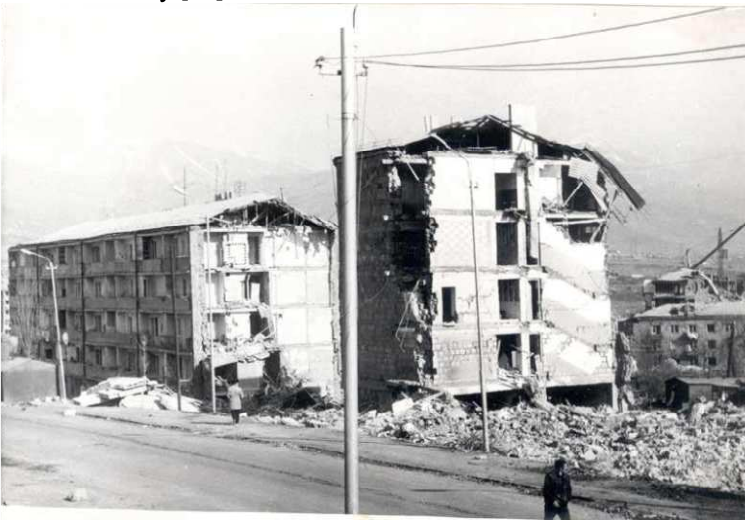
Рис. 6. Последствия землетрясения в г.Спитак,1989г
