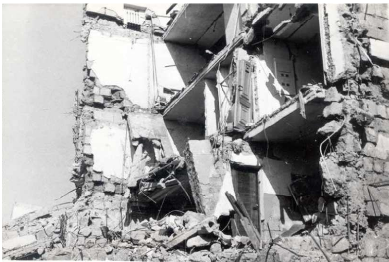
Рис. 7. Последствия землетрясения в г.Спитак, 1989г
