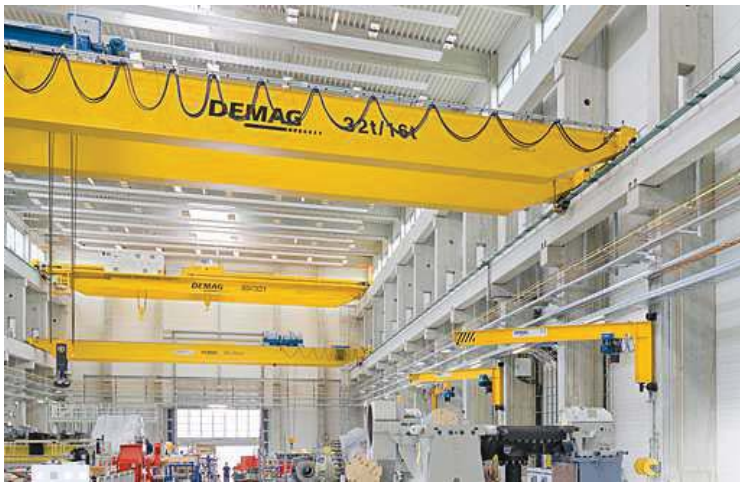
Рис. 1. Виробничий цех, оснащений мостовими кранами фірми Demag
