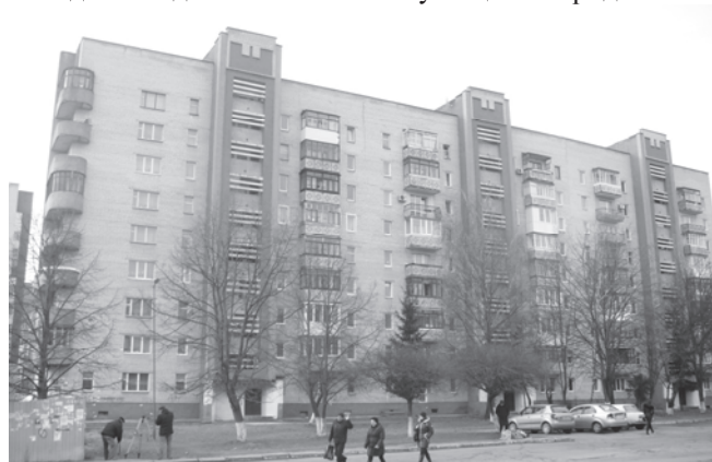
Фото. 1. Фасад будівлі по осі А
