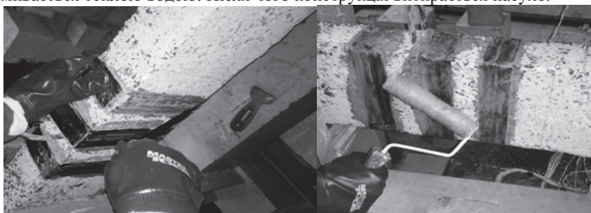
Рис. 3. Наклеювання першого шару та вкатування полотна Sika Wrap®
