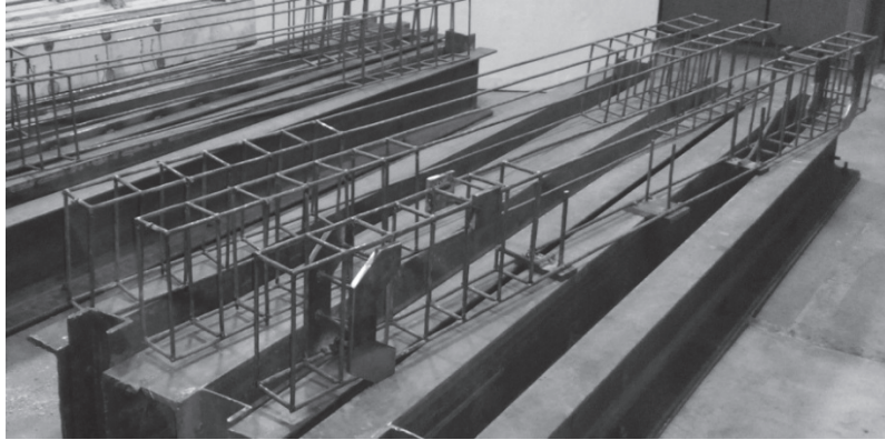
Рис. 1. Загальний вигляд арматурних карасів із закладними деталями
