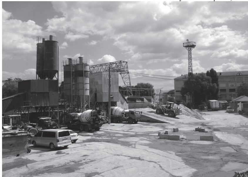
Рис. 4. Загальний вигляд бетонозмішувального вузла
