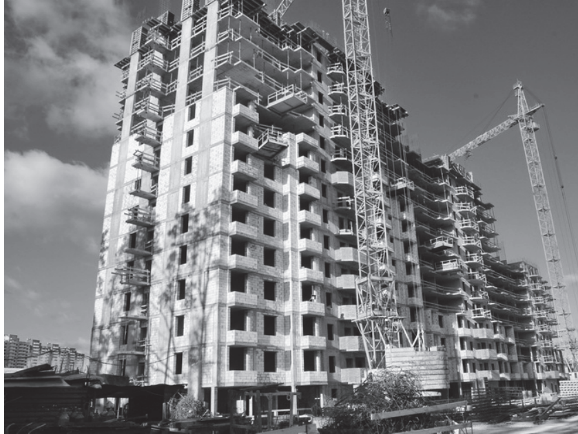
Рис. 3. Загальний вигляд монолітно-каркасного будинку в м. Київ, вул. Пономарьова, 26.
