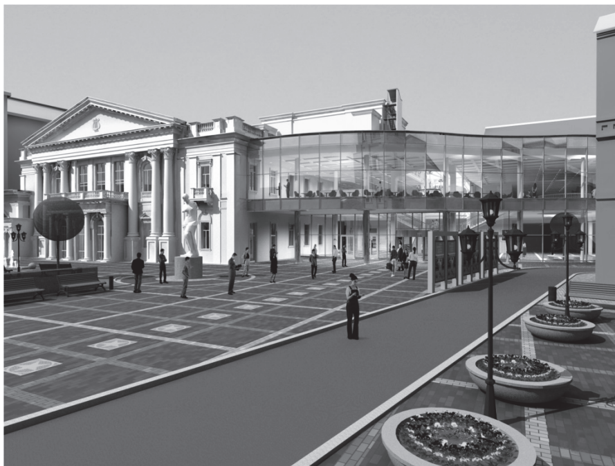
Рис. 1 Общий вид здания
