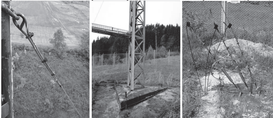
Фото 2. Вузли кріплення відтяжок, база щогли
