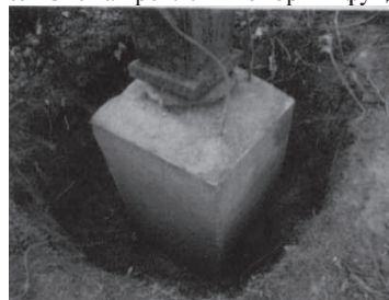
Рис.2 Схема крепления опоры к фундаменту
