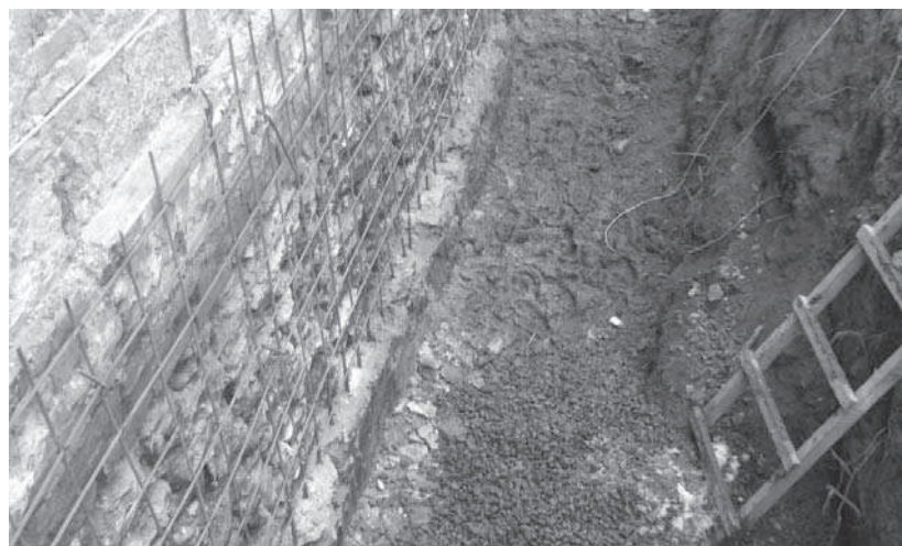
Рис. 3. Влаштування арматури пристінних бенкетів
