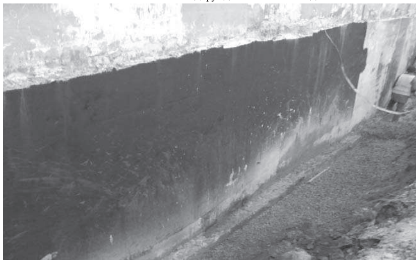
Рис. 4. Зовнішній вигляд фундаментів після підсилення
