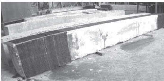
Рис. 6. Загальний вигляд балки після підсилення вуглецевим полотном
