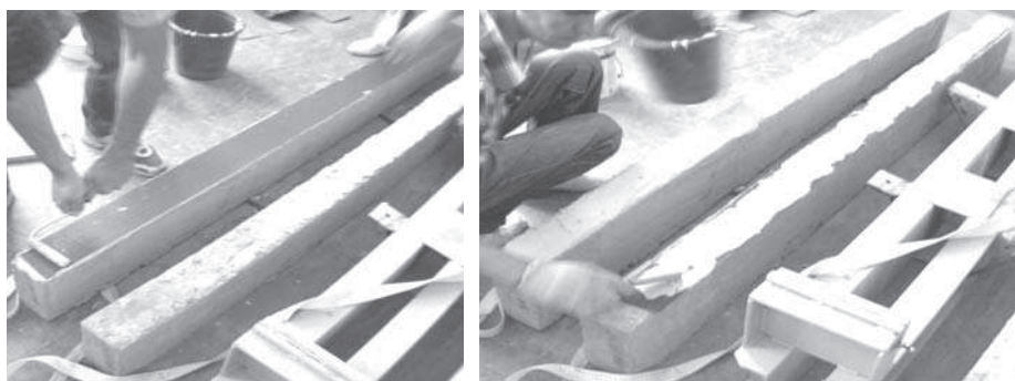
Рис. 4. Процес підсилення балок розтягнутої зони вуглеполімерним волокном
