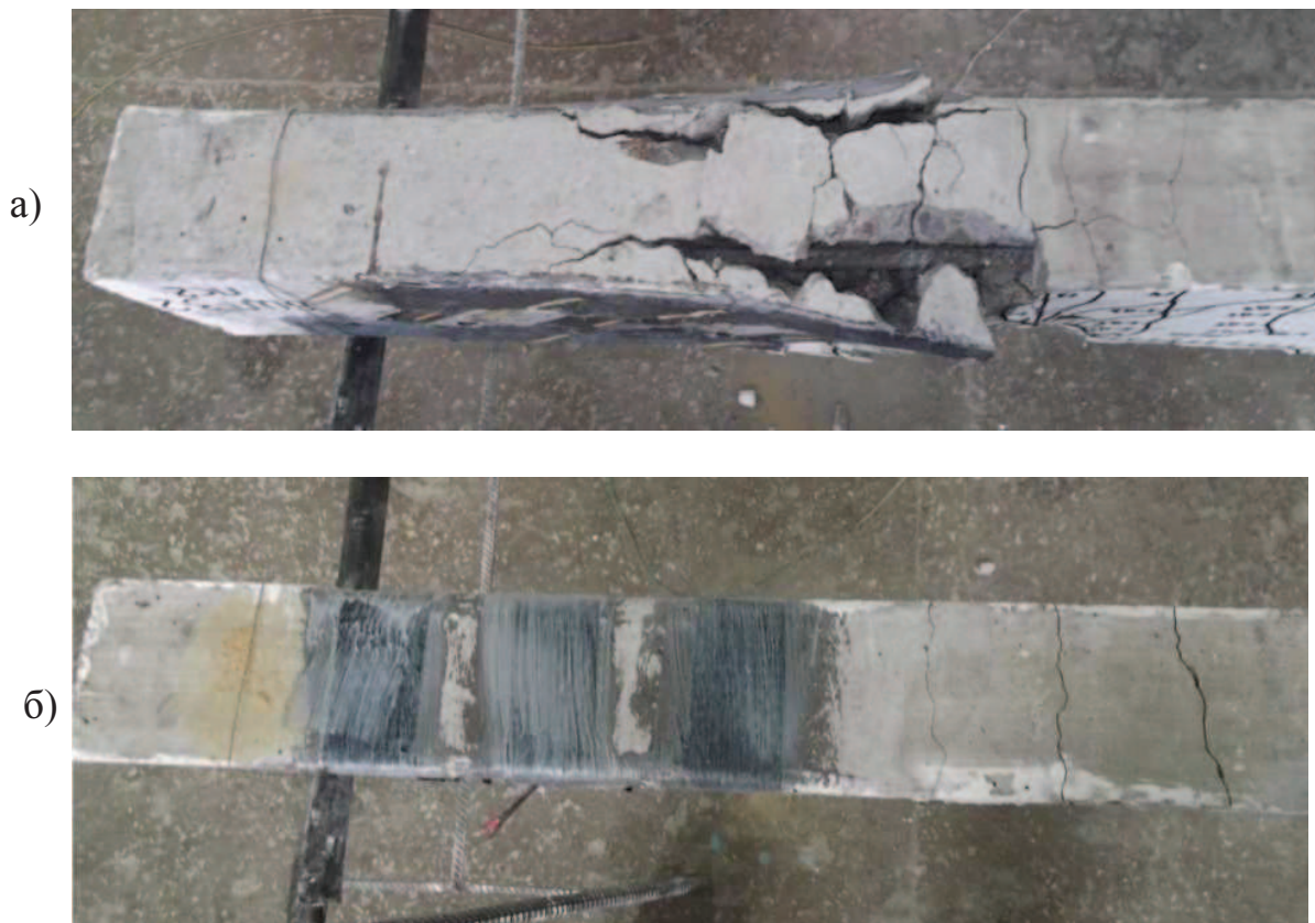
Рис. 3. Нижня грань підсилених балок в приопорній зоні після їх руйнування:
