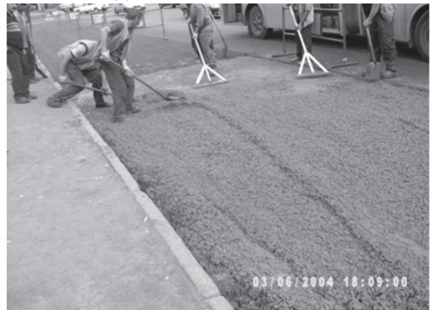
Рис.3. Розподілення СФБ перед укоченням
