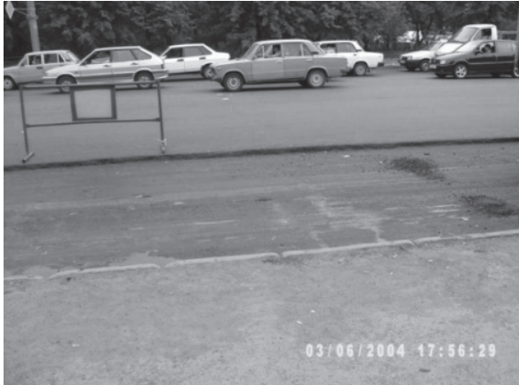
Рис .1. Фрезування ділянки
