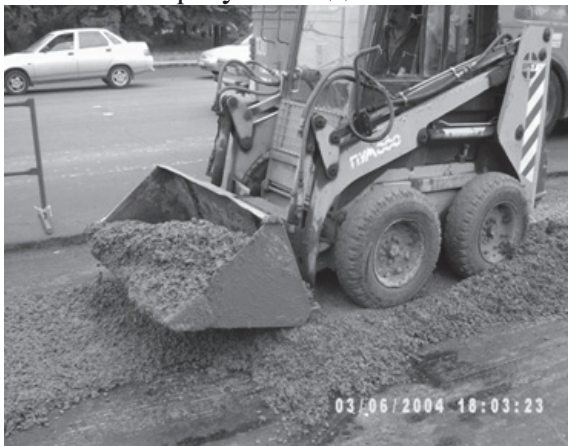
Рис.3. Розподілення СФБ перед укоченням
