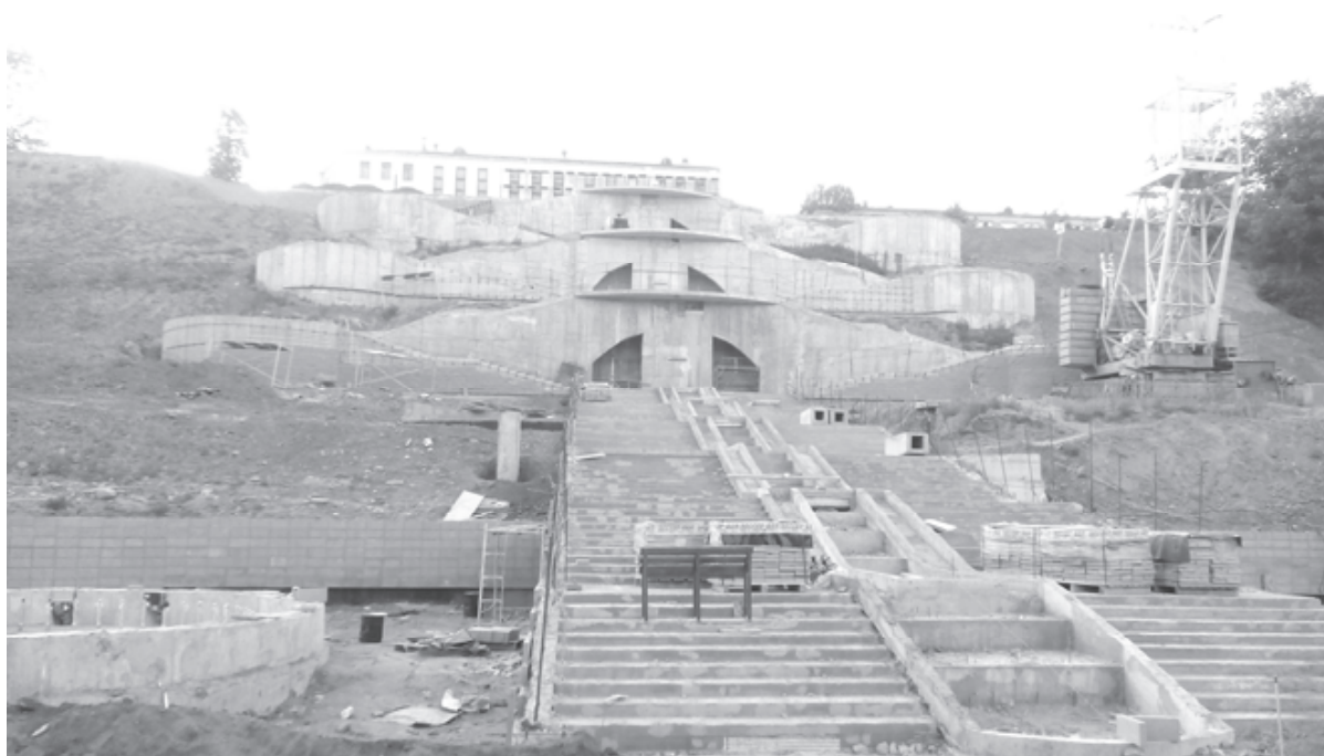
Рис. 4. Общий вид склона после устройства основных бетонных работ
