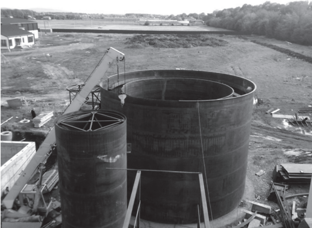
Рис. 3. Монтаж очисних споруд забійного цеху ТОВ «Драчинецьке-1»
