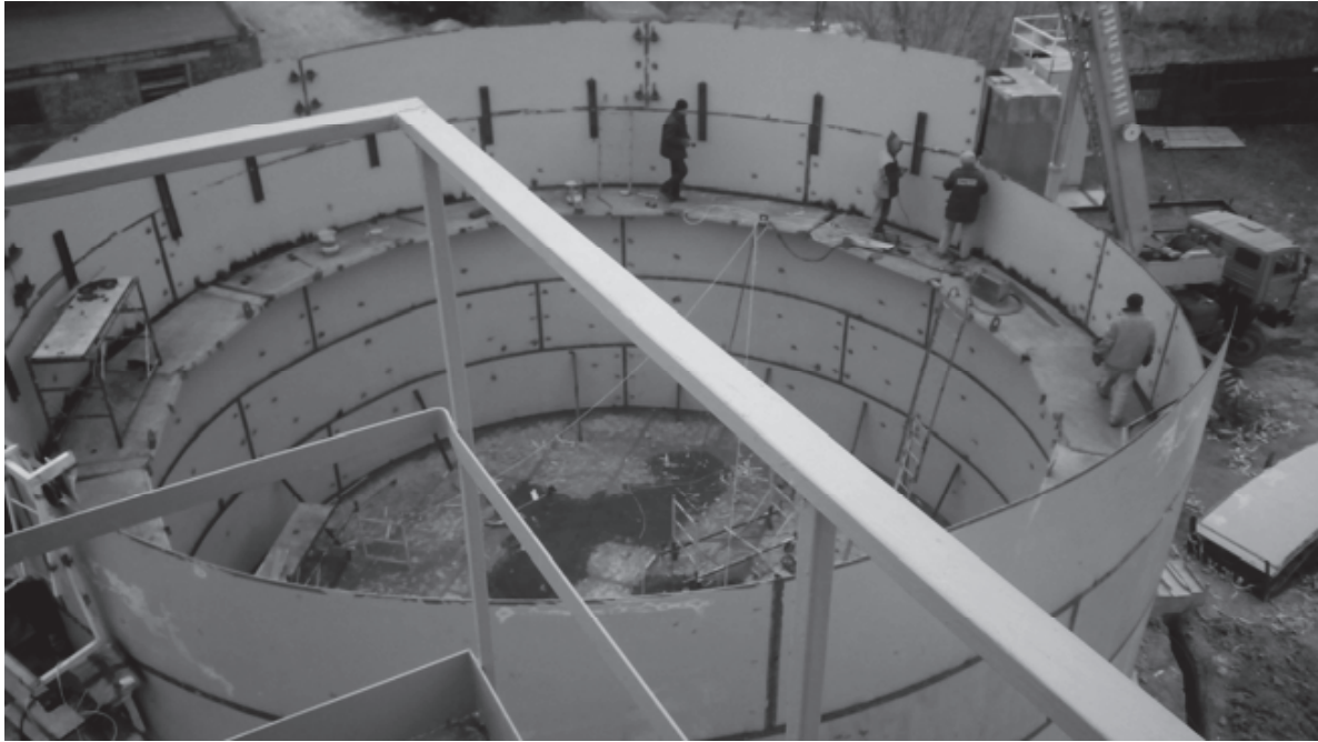
Рис. 4. Монтаж аеротенка-відстійника на Золотоніському маслоробному комбінаті
