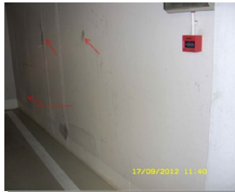
Fotografia. 5 a, b. Zawilgocenia na ścianach zewnętrznych garażu.
