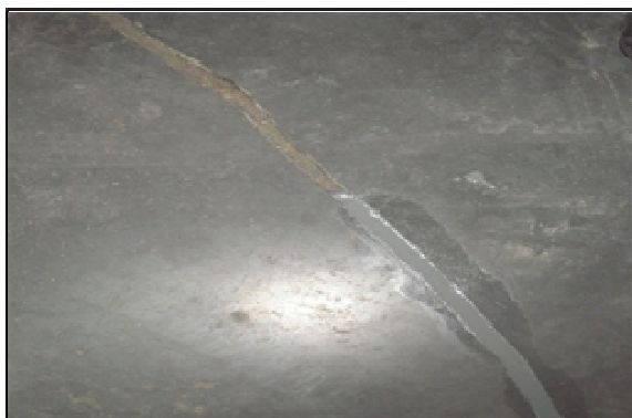
Fot. 9. Rysa wypełniana grawitacyjnie
