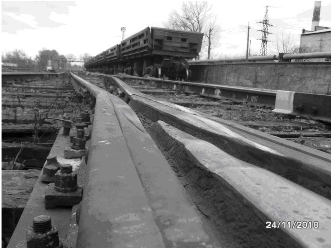
Рисунок 1 – Спрацьовані частини елементів хрестовини
