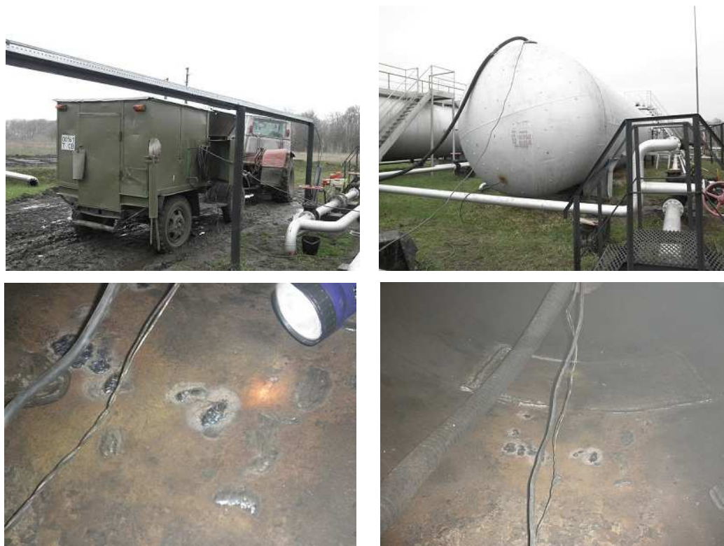
Рисунок 4 – Ремонт і контроль виконання зварювальних робіт
