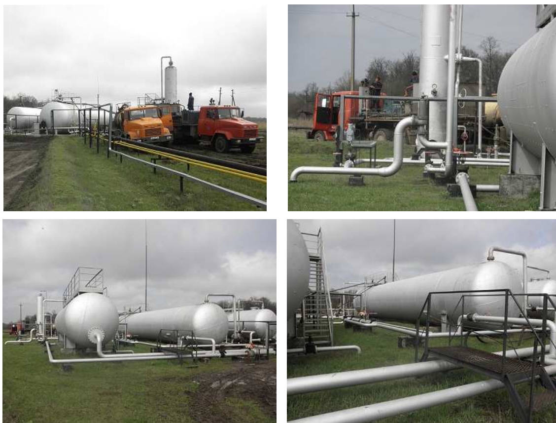
Рисунок 5 – Проведення гідравлічного випробування смності ПЕ 200-16 ГС
