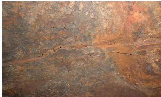
Рисунок 1 – Наскрізна корозія нижніх твірних обичайки, в місці входу продукції свердловин нафтогазового сепаратора НГС-1-1,0-3000-2
