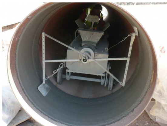
Рисунок 12 – Нанесення цементно-піщаного покриття на внутрішню поверхню дефектного сталевго трубопроводу облицювальним агрегатом
