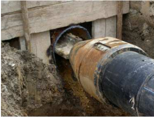
Рисунок 6 – Розширювач для руйнування дефектного металевго трубопроводу
