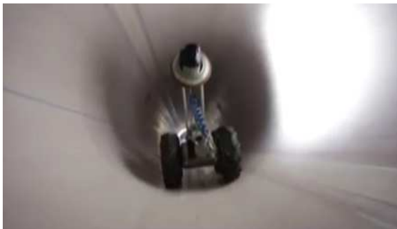
Рисунок 4 – Контроль внутрішньої порожнини трубопроводу самохідною відеокамерою
