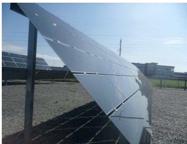
Рис. 9. Подсистема солнечной станции из панелей BS-50
