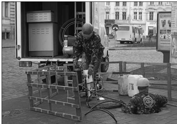
Рис. 3. Мобільний діагностично-відновлювальний комплекс під час робіт з відновлення каналізаційного колектора на проспекті Свободи у Львові
