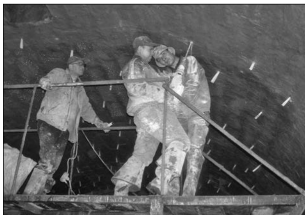
Рис. 2. Працівники ДППЦ «Техно-Ресурс» НАН України бурять отвори для ін'єктування в каналізаційному колекторі на проспекті Свободи у Львові
