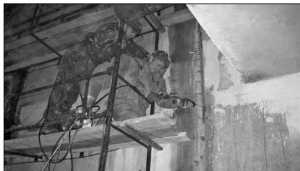
Рис. 9. Ін'єктування пінополіуретанових композицій в греблю Ташлицької ГАЕС
