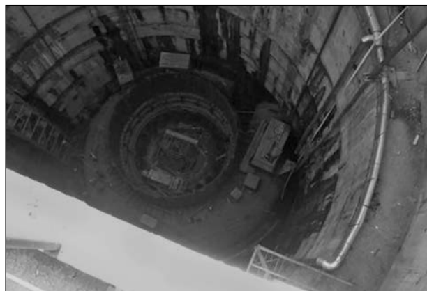
Рис. 10. Залізобетонна шахта турбінного залу Дністровської ГАЕС, де проводили ін'єкційне зміцнення та блокування зон просочування води
