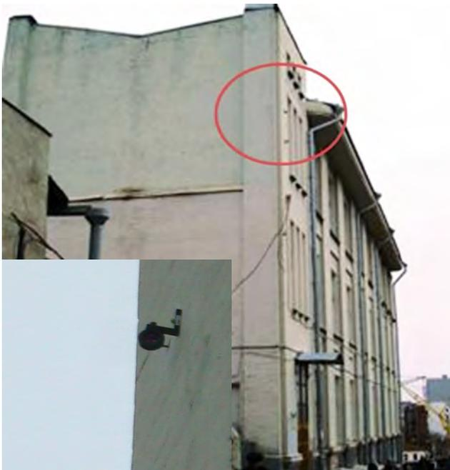
Рис. 7. Вид и расположение закрепленного отражателя
