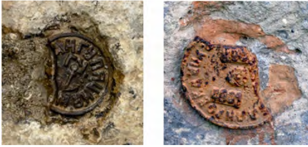
Рис. 1. Пошкоджені геодезичні марки
