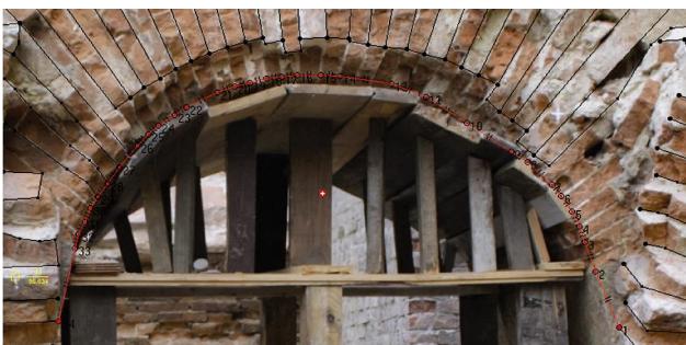
Рис. 9. Стереоскопічне маркування 1-го контуру – арки № 1 (контур позначено червоним кольором)
