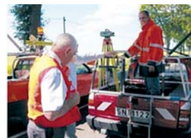
Проведення моторизованого нівелювання I класу
