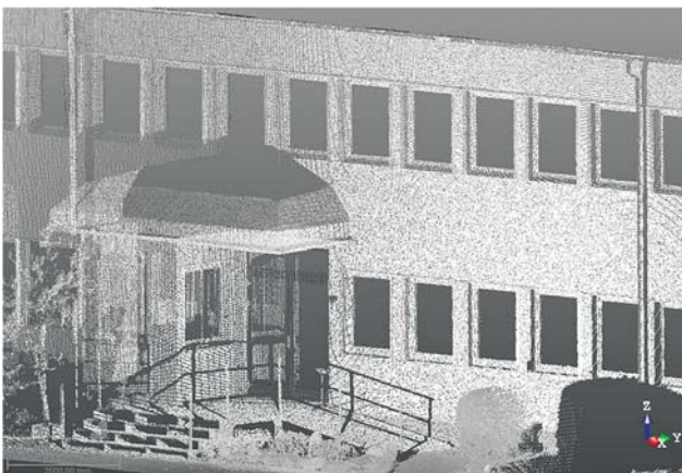
Рис. 2. Зображення будівлі НДГТКІ, отримане із хмари точок під час лазерного сканування
