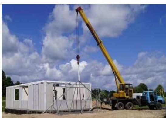
**T<sub>p</sub>-3** - сэндвич панель из легкого стального каркаса. Была рассмотрена стеновая панель компании «Меттэм», которая состоит из стального термо-профильного каркаса, окрашенной фиброкерамической плиты и гипсо-стружечной плиты в качестве наружной и внутренней обшивки и базальтового утеплителя.
