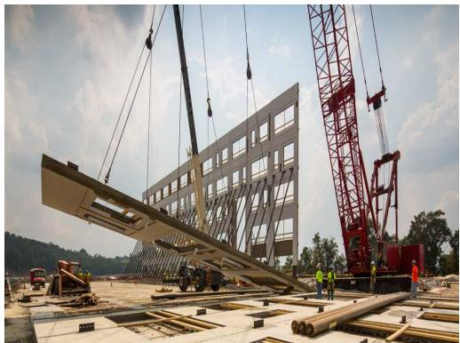
формируются части стен, укладывается арматура, размещаются закладные детали и укладывается бетон. После набора необходимой прочности производится монтаж конструкций стен при помощи крана.
