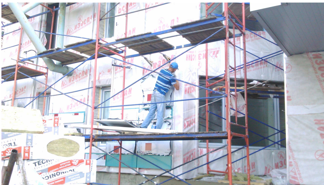
Рис. 1. Влаштування теплоізоляції будівлі способом «вентильований фасад»
