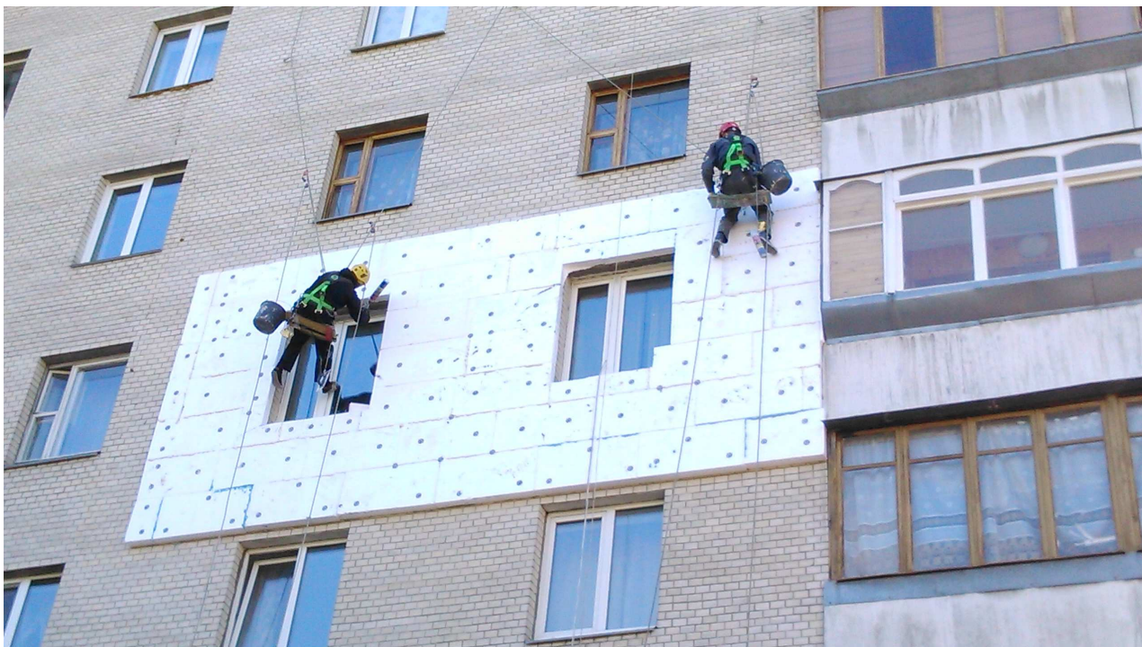
Рис. 2. Утеплення зовнішніх стін частини будівлі ланкою альпіністів
