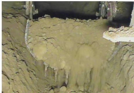
Рис.1 – Фото процесу підрізання і розпушення ґрунтового масиву лемешем зі змінною поверхнею
