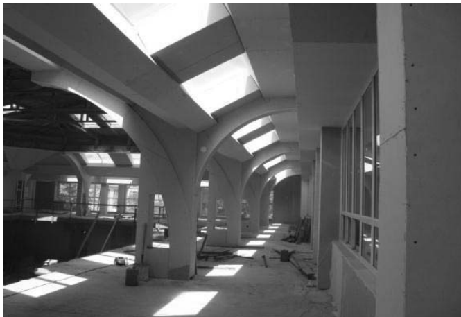
Рис. 2. Строительные работы в рекреационной зоне главного учебного корпуса ДонНАСА
