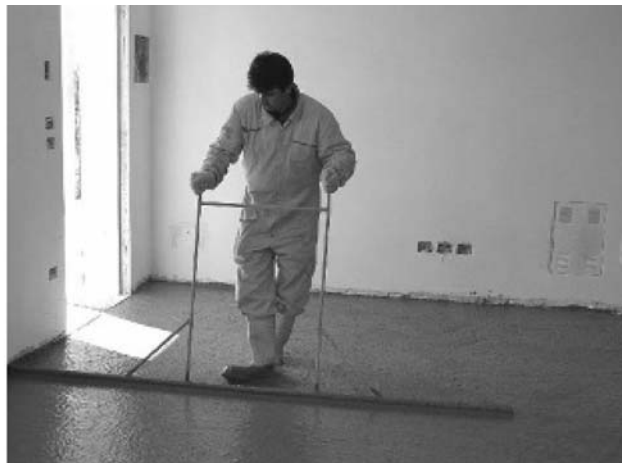
Рис. 1. Наливные полы помещения завода «Преобразователь», г. Запорожье
