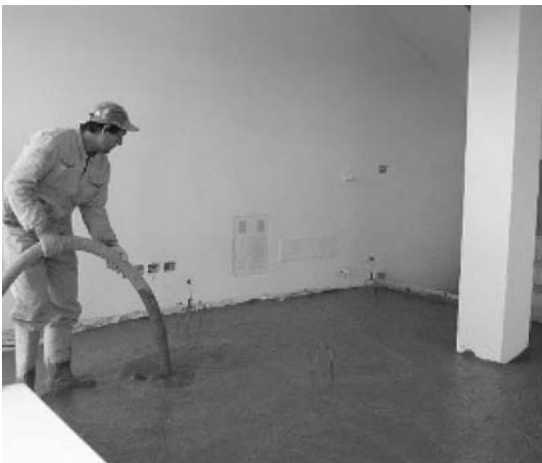
Рис. 1. Наливные полы помещения завода «Преобразователь», г. Запорожье
