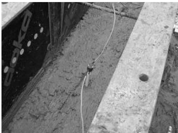
Рис. 3. Определение температуры твердения бетонной смеси при возведении фундамента таможенного терминала
