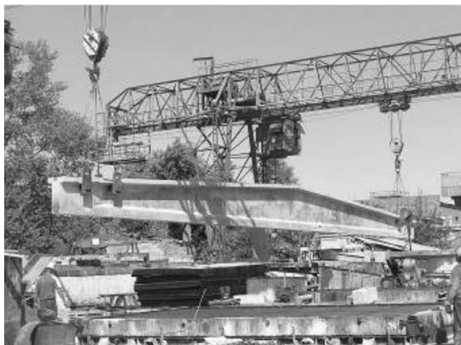
Рис. 4. Производство 30-метровых балок перекрытия на ЗАО «ЗЖБК №1», г. Запорожье
