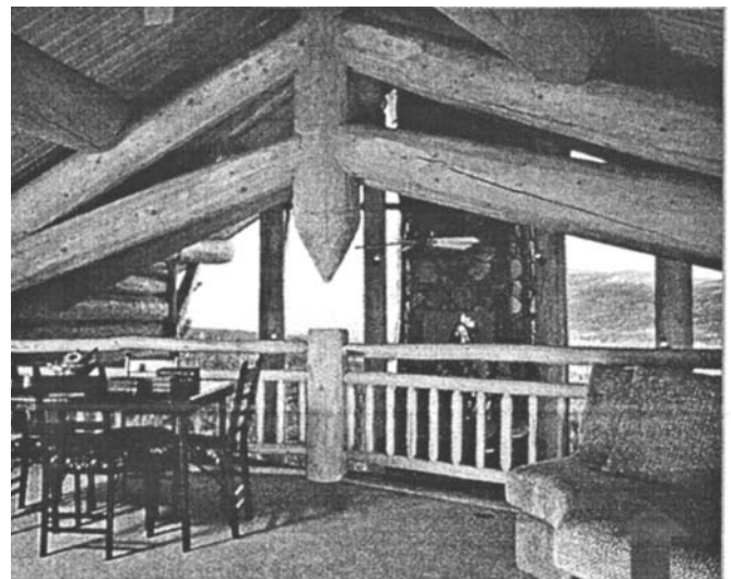
Фото 2. Несуча конструкція даху
