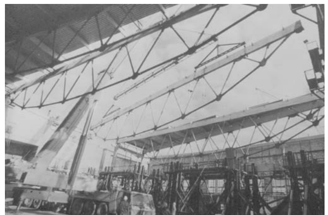
Рис. 3. Металодерев'яна ферма прольотом 53 м
