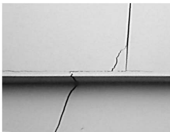
Фото. 1. Характерные дефекты в гипсокартонных конструкциях
