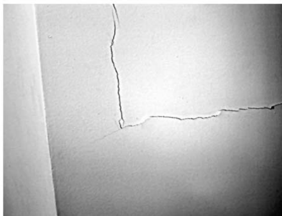
Фото. 1. Характерные дефекты в гипсокартонных конструкциях
