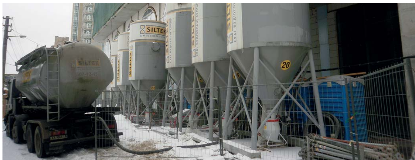
Рис. 4. Використання силосної технології при влаштуванні штукатурного покриття у зимову пору року
