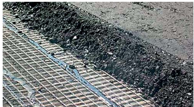
Рис. 3. Влаштування бетонної основи з малоцементних жорстких бетонних сумішей, що вкладаються трамбуванням або механічними котками.
