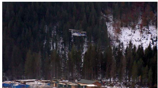
Рис. 2. Подання бетонних сумішей при будівництві фундаментів опор витягів гірськолижних трас взимку, курорт Буковель.
