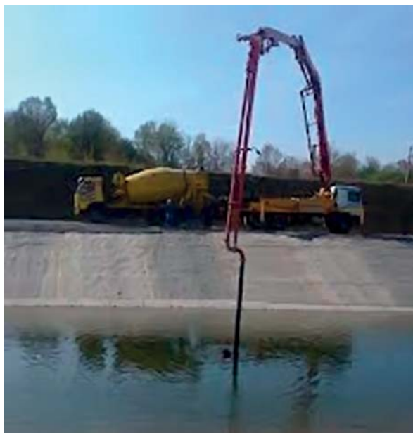
Рис. 4. Підводне бетонування прямим подаванням бетонної суміші.
