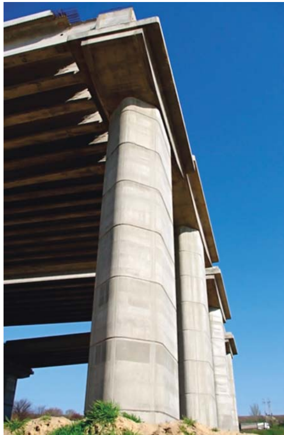
Будівництво мостів через р. Дніпро, м. Запоріжжя
