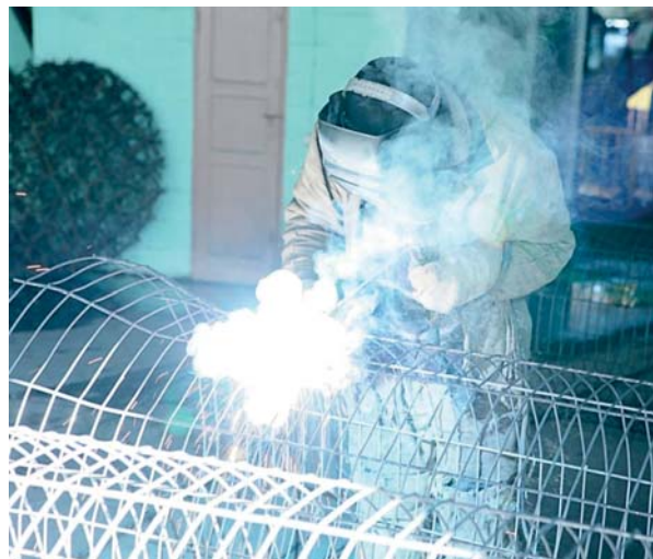
Рис. 3. ПАТ «Комбінат будіндустрії» зварювання арматурного каркасу для труби розтрубної
